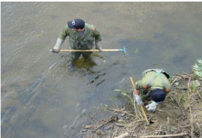
Entfernung der angesammelten Äste bei der Rabnitzbrücke durch die Kameraden aus Strebersdorf
